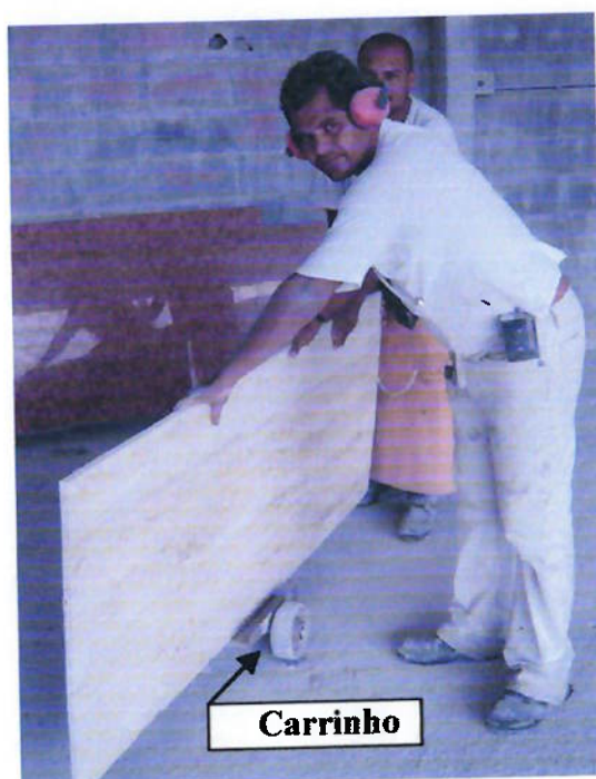
Fig. 8.4 - Carrinho para deslocamento de chapas
